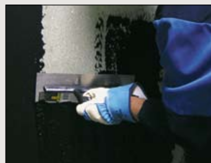
Application à la taloche de plâtrier
